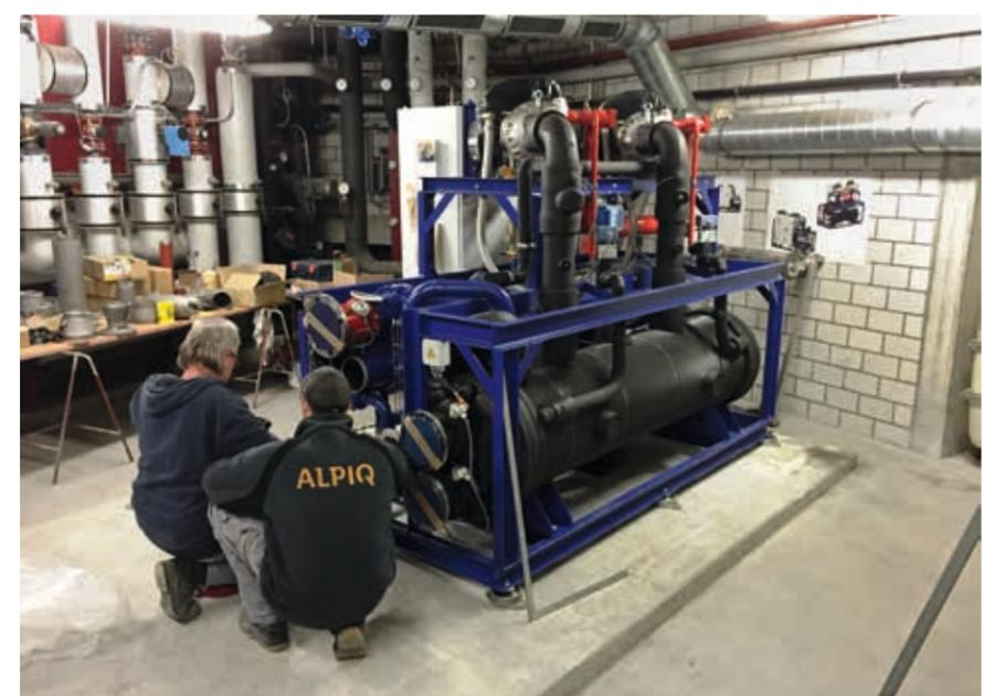
Die zwei Turbocore Kaltwassersätze, speziell in den FCB-Farben angefertigt, unter der Gästetribüne liefern mit je 600KW das Kaltwasser für die Klimaanlage.
